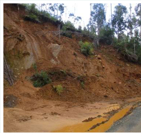
Deslizamiento en Mehuín, comuna de Mariquina. Archivo de terreno.
